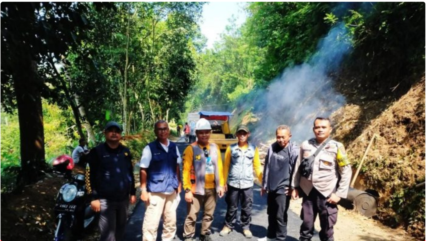
Bhabinkamtibmas Desa Munjul Polsek Nagrak Monitor Pembangunan Jalan Desa
